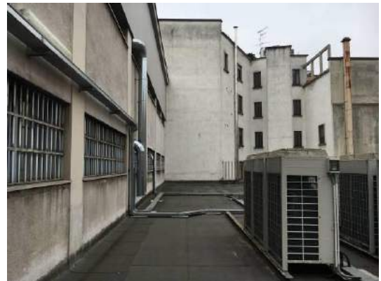
Vista esterna - copertura
