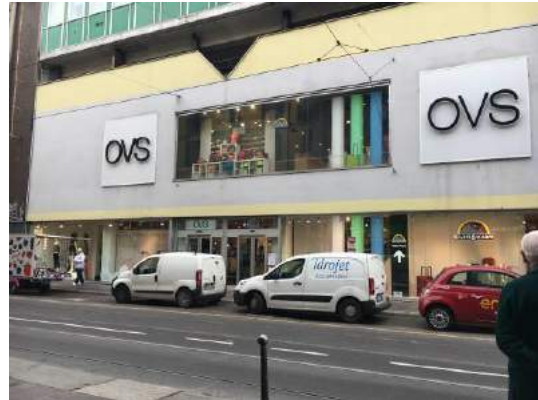
Vista esterna – Ingresso
