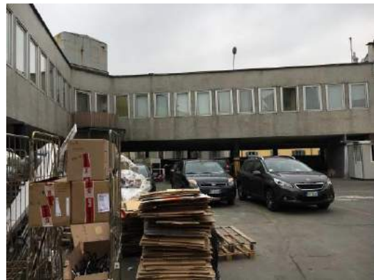
Vista esterna – Copertura
