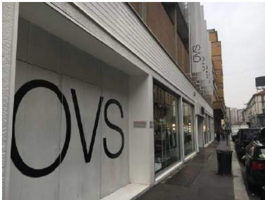
Uscita di sicurezza – V. Marghera
