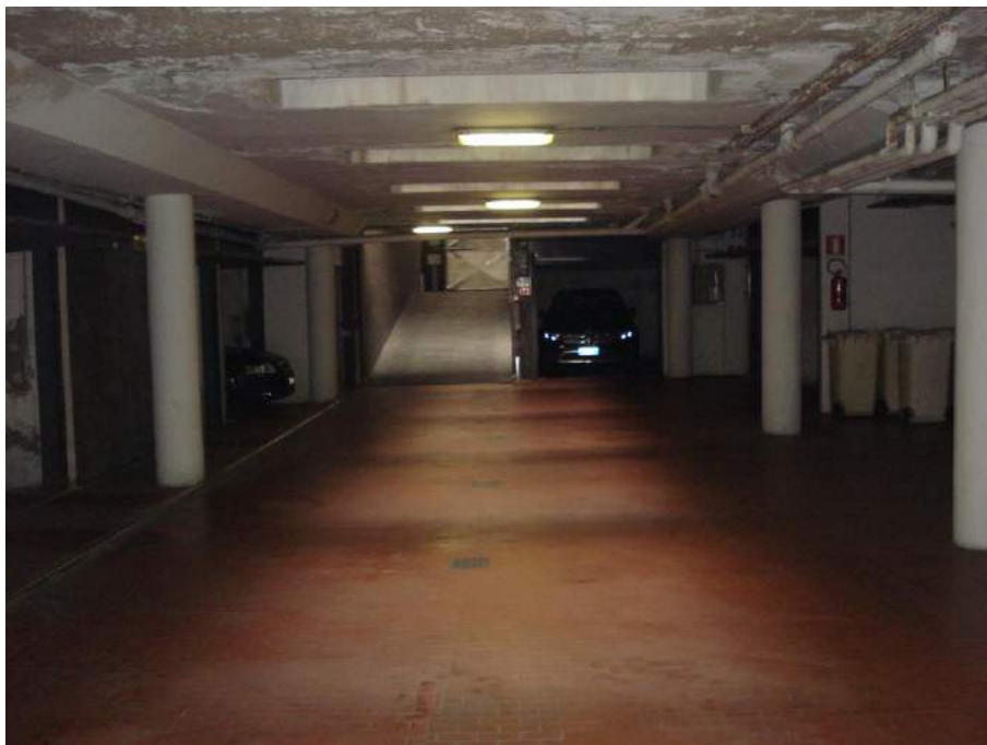
Foto interna – piano autorimessa
