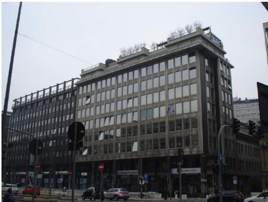
Foto esterna – Prospetti su Via Vittor Pisani e Via Zanon
