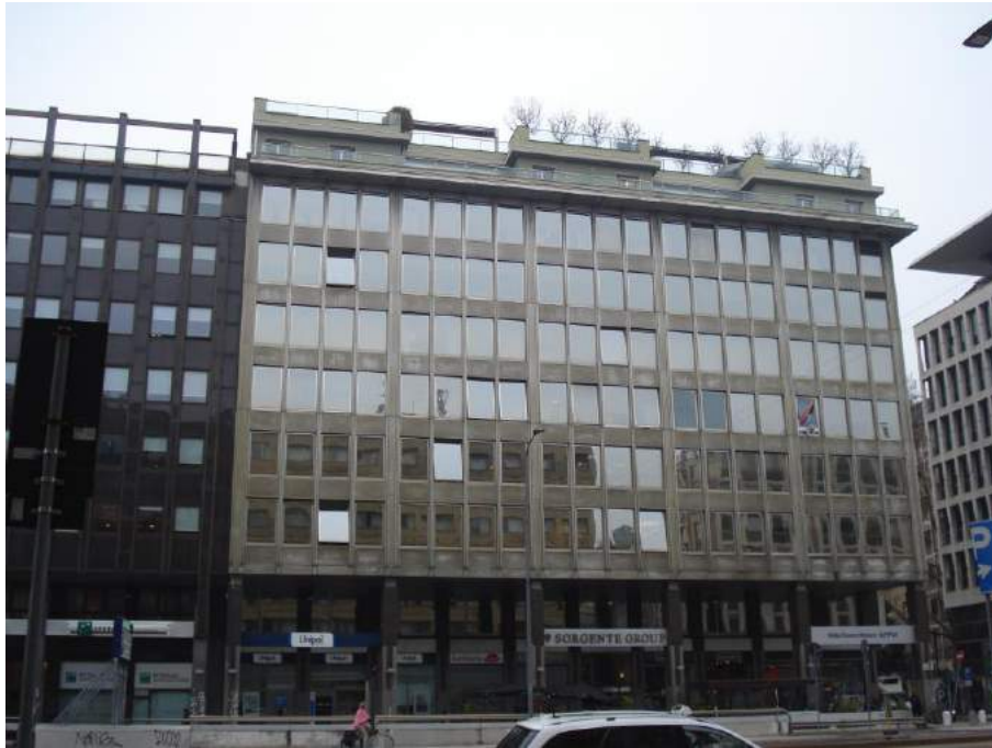
Foto esterna – Prospetto su Via Vittor Pisani
