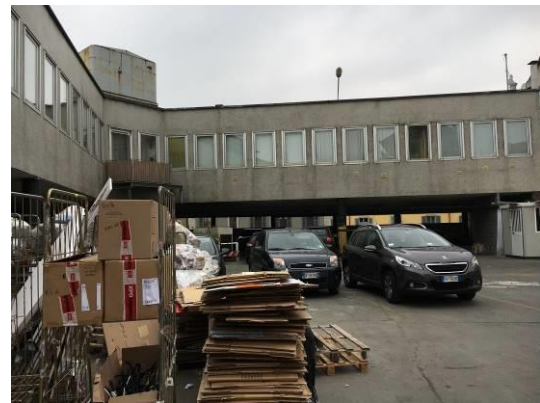
Vista esterna – Copertura
