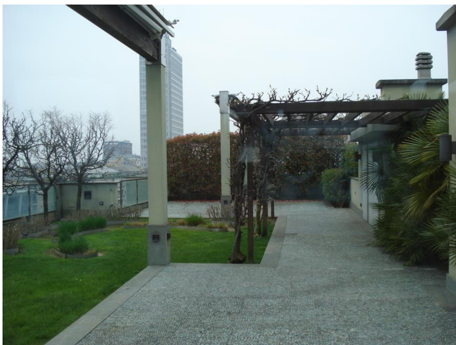
Foto esterna – garden roof
