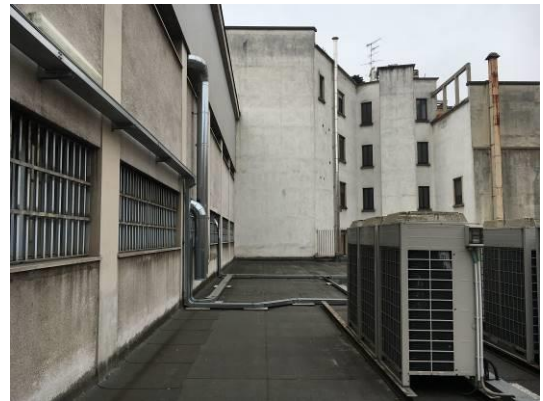
Vista esterna - copertura
