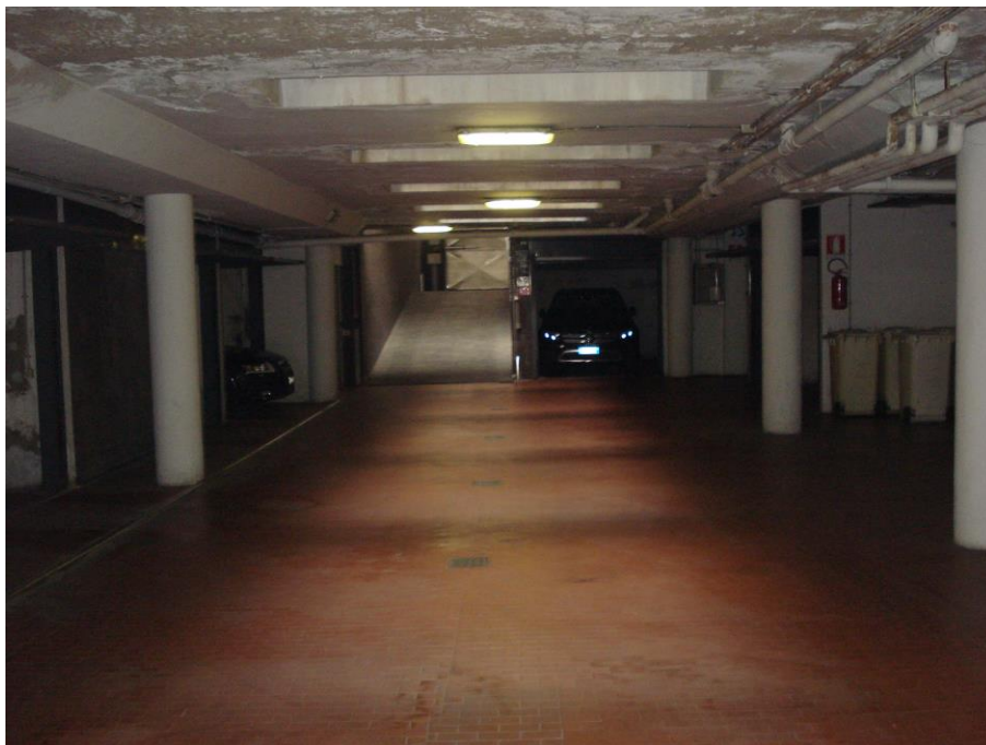
Foto interna – piano autorimessa
